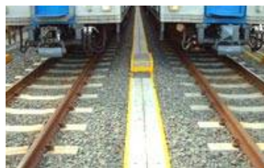
PCマクラギを再利用した構内通路
